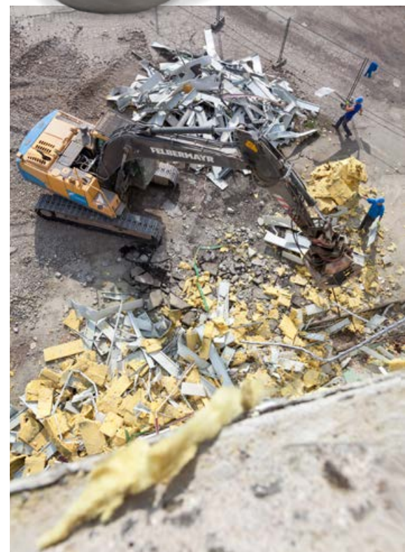
Resturile de materiale de construcție au fost deja sortate la fața locului, corespunzător posibilităților de revalorificare.
