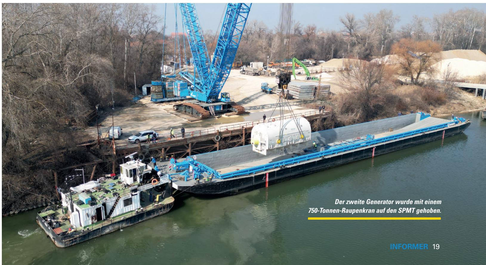
**Der zweite Generator wurde mit einem 750-Tonnen-Raupenkran auf den SPMT gehoben.**
