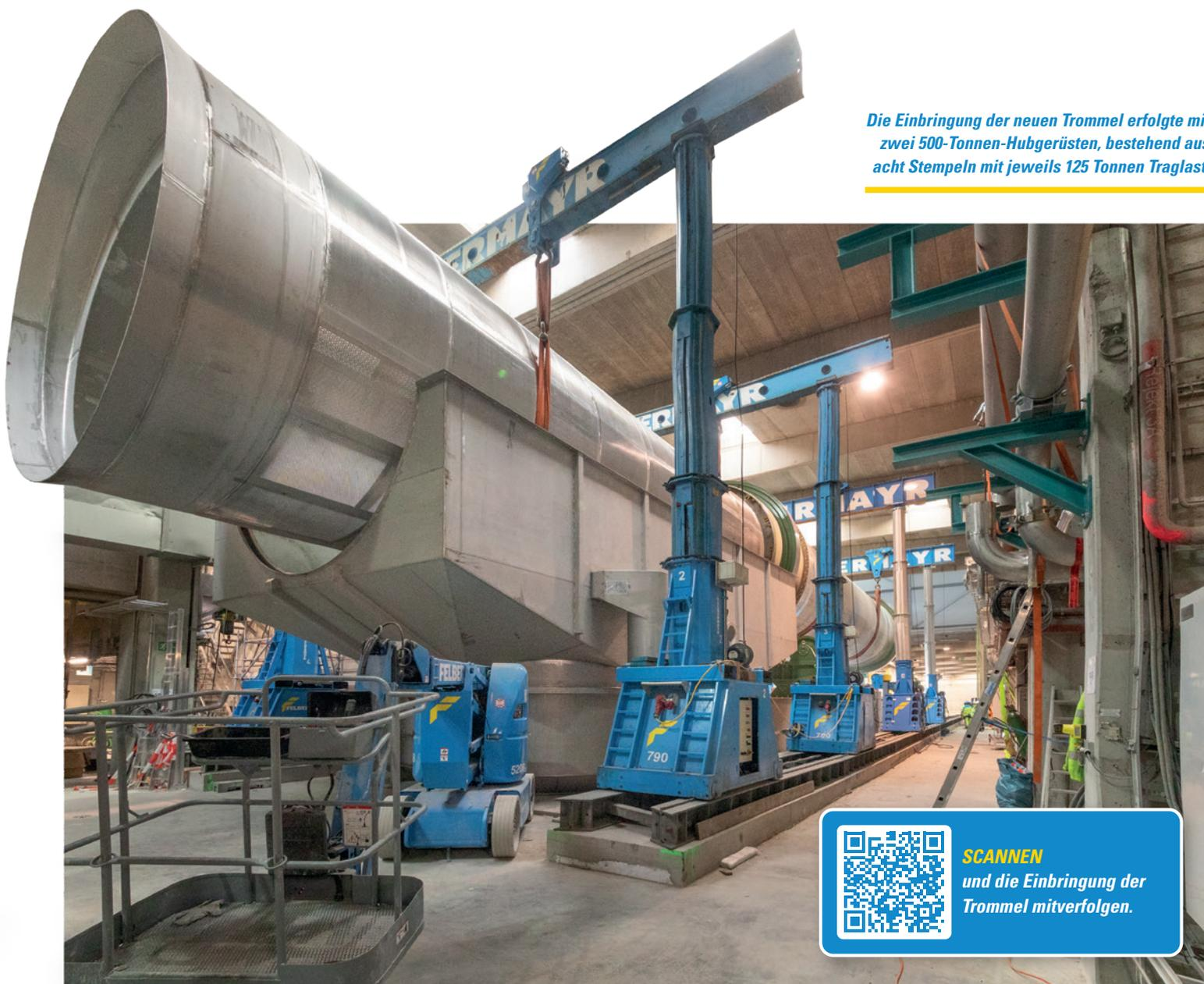
Die Einbringung der neuen Trommel erfolgte mit zwei 500-Tonnen-Hubgerüsten, bestehend aus acht Stempeln mit jeweils 125 Tonnen Traglast.
