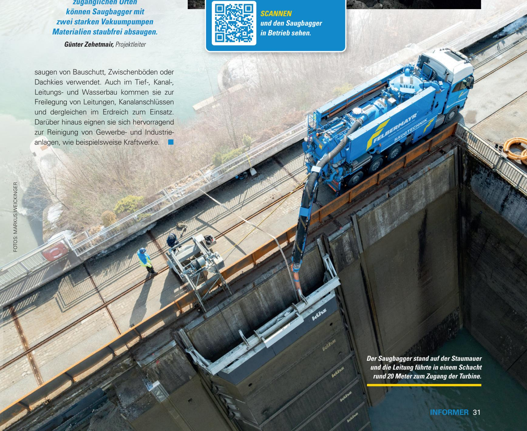
**Der Saugbagger stand auf der Staumauer und die Leitung führte in einem Schacht rund 20 Meter zum Zugang der Turbine.**
