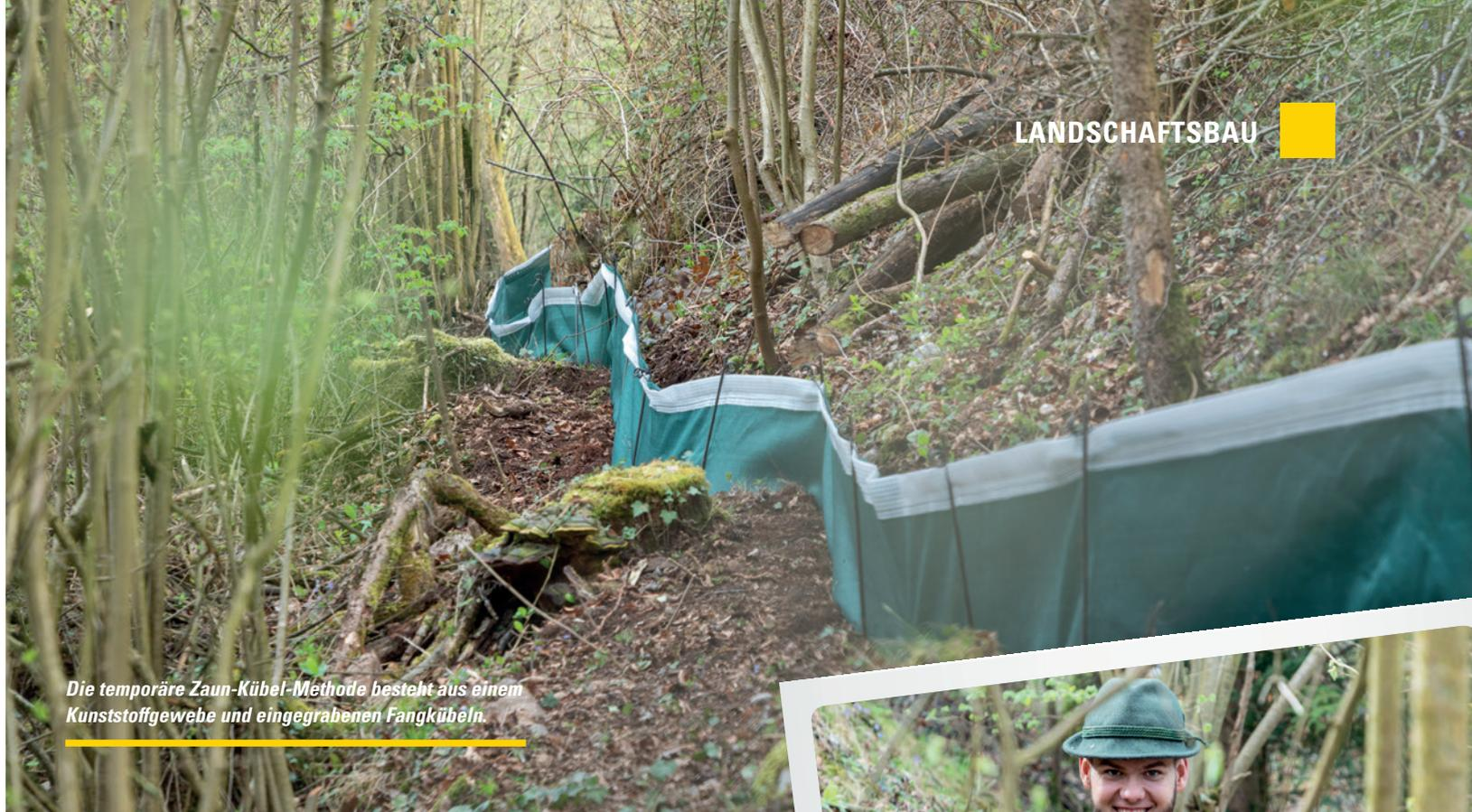
Die temporäre Zaun-Kübel-Methode besteht aus einem Kunststoffgewebe und eingegrabenen Fangkübeln.
