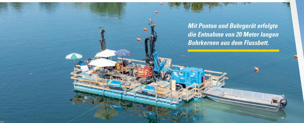
Mit Ponton und Bohrgerät erfolgte die Entnahme von 20 Meter langen Bohrkernen aus dem Flussbett.
